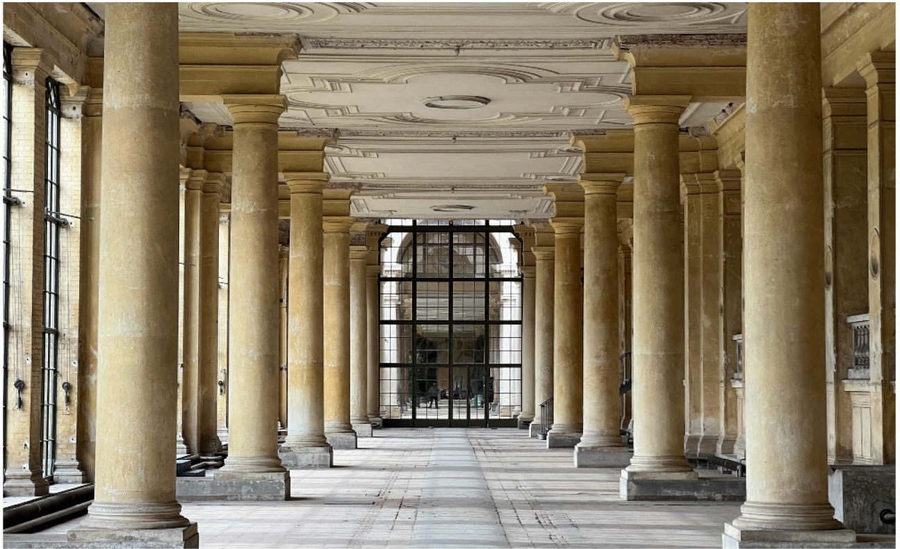
Abb. 03 2024-09-26 FEB_090 OR.JPG Östliche Pflanzenhalle - Blickrichtung zum Säulenhof, Vorzustand 2024
