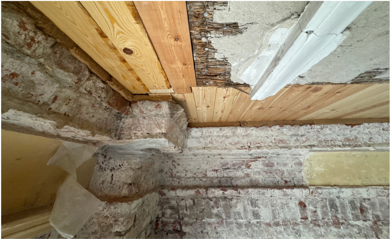
Abb. 09 IMG_9490.JPG Östliche Pflanzenhalle - Deckenschlaung ergänzt, Joch 2
