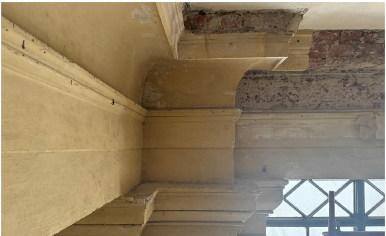
Abb. 10 IMG_9431.JPG Östliche Pflanzenhalle - Gesims, Südfassade
