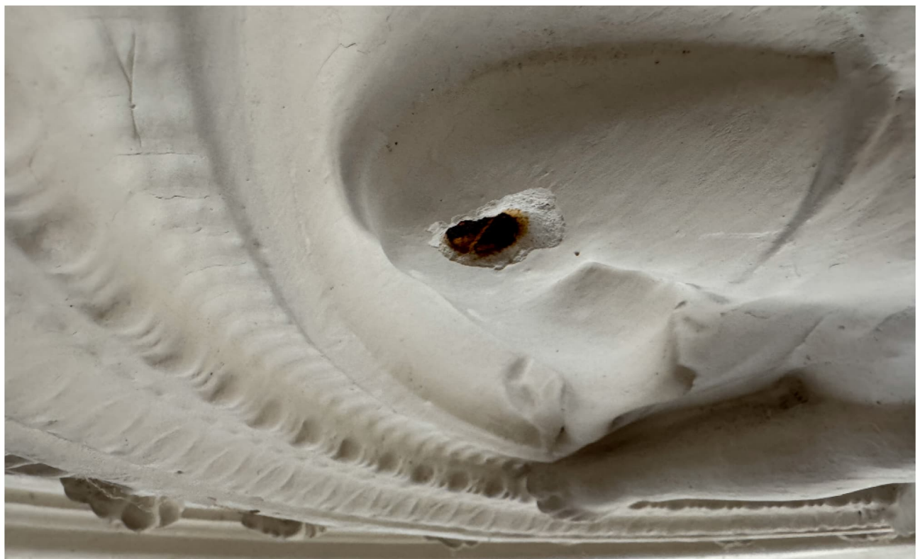
Abb. 18 20206-03-06 ML_024 OR.JPG Östliche Pflanzenhalle - Deckenmedaillon, Joch 1
