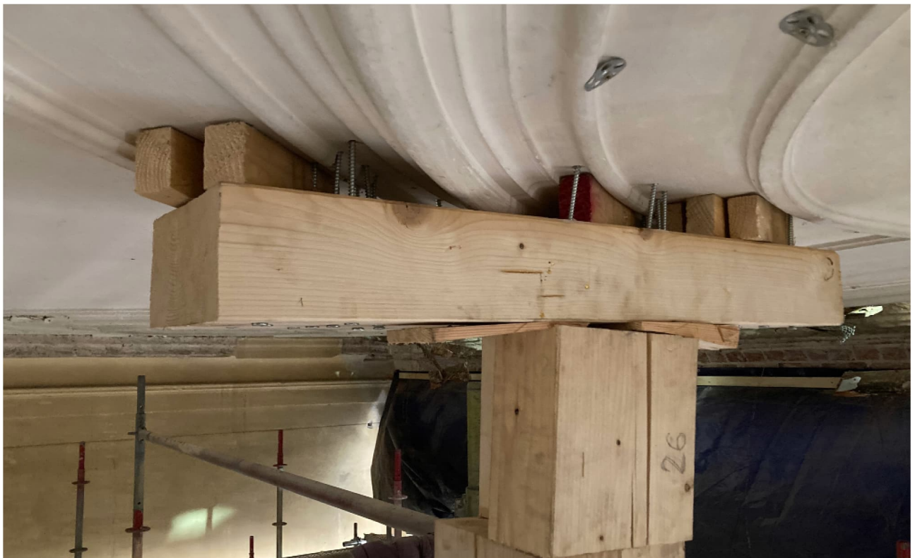
Abb. 23 2025-06-25 AM_017 OR.JPG Östliche Pflanzenhalle - Abspreiung der Decke für Sanierungsarbeiten am Dachstuhl
