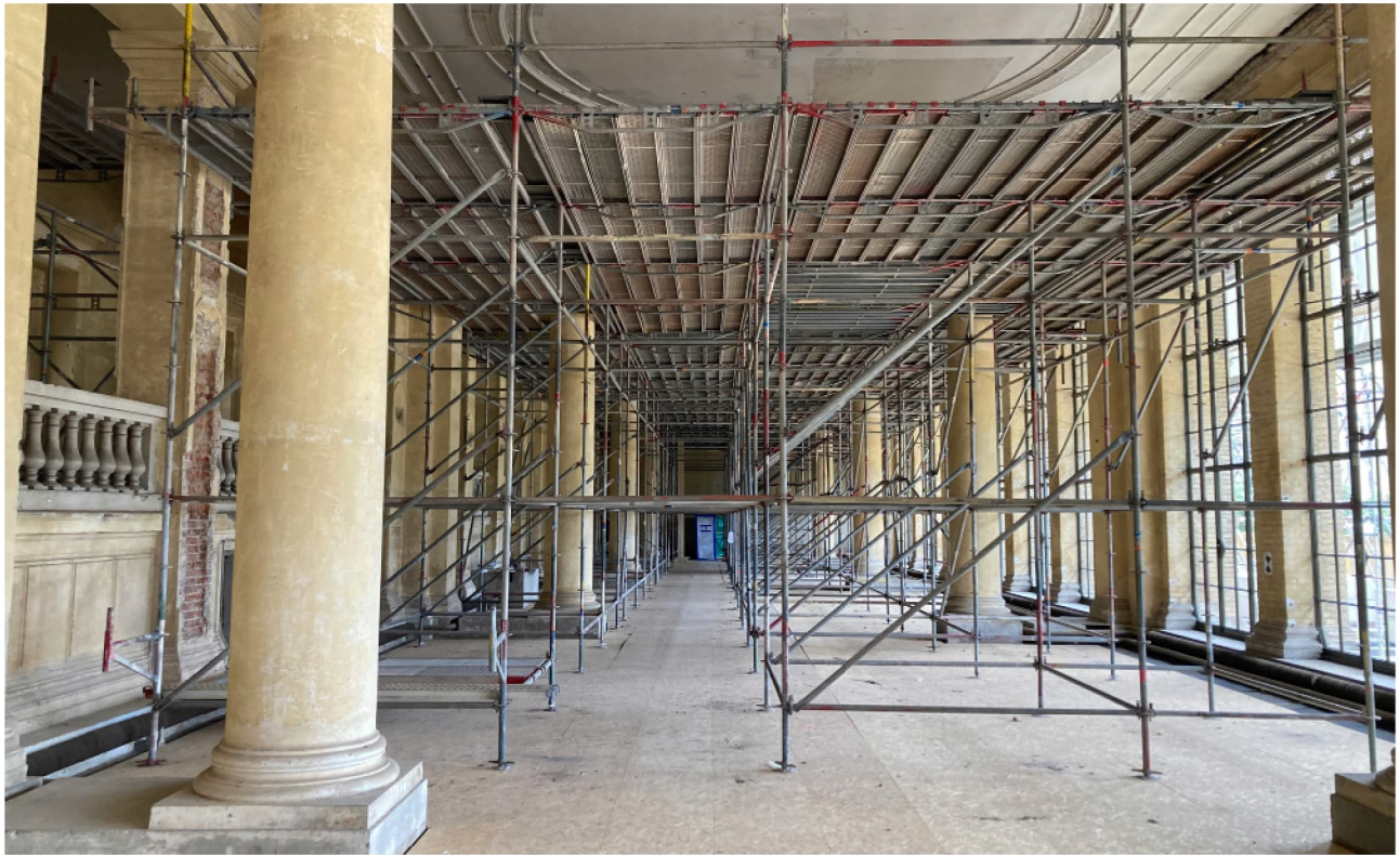
Abb. 27 2025-06-25 AM_007 OR.JPG Östliche Pflanzenhalle - Raumgerüst, Teilaufbau noch ohne Arbeitsebenen, nach Baubeginn Sanierung Dachstuhl 2025
