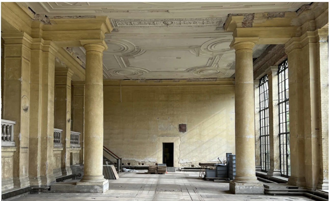
Abb. 04 2024-09-26 FEB_089 OR.JPG Östliche Pflanzenhalle - Blickrichtung zum Übergang in den NOP, Vorzustand 2024
