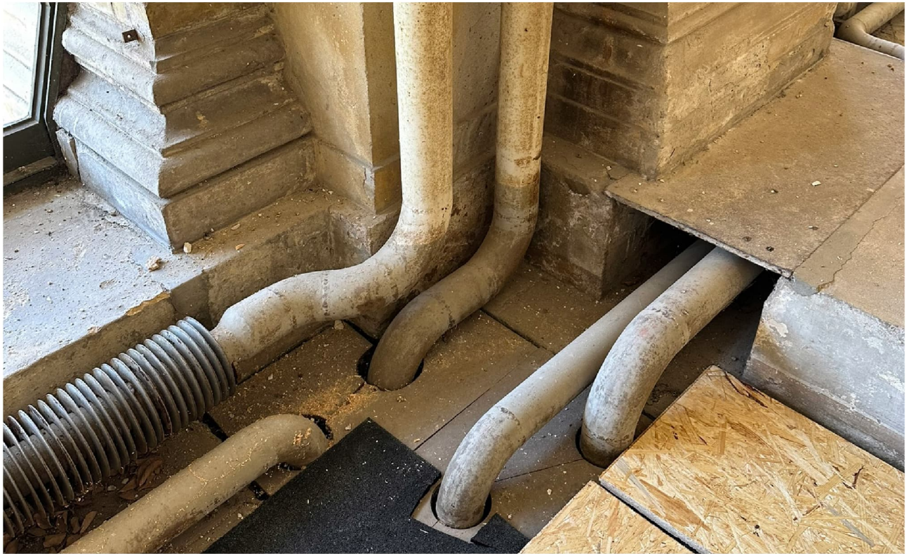
Abb. 29 2025-08-21 MJ_047 OR_OPH Joch 5 - SW.JPEG Östliche Pflanzenhalle - Warmluftheizung mit Rippenheizrohren
