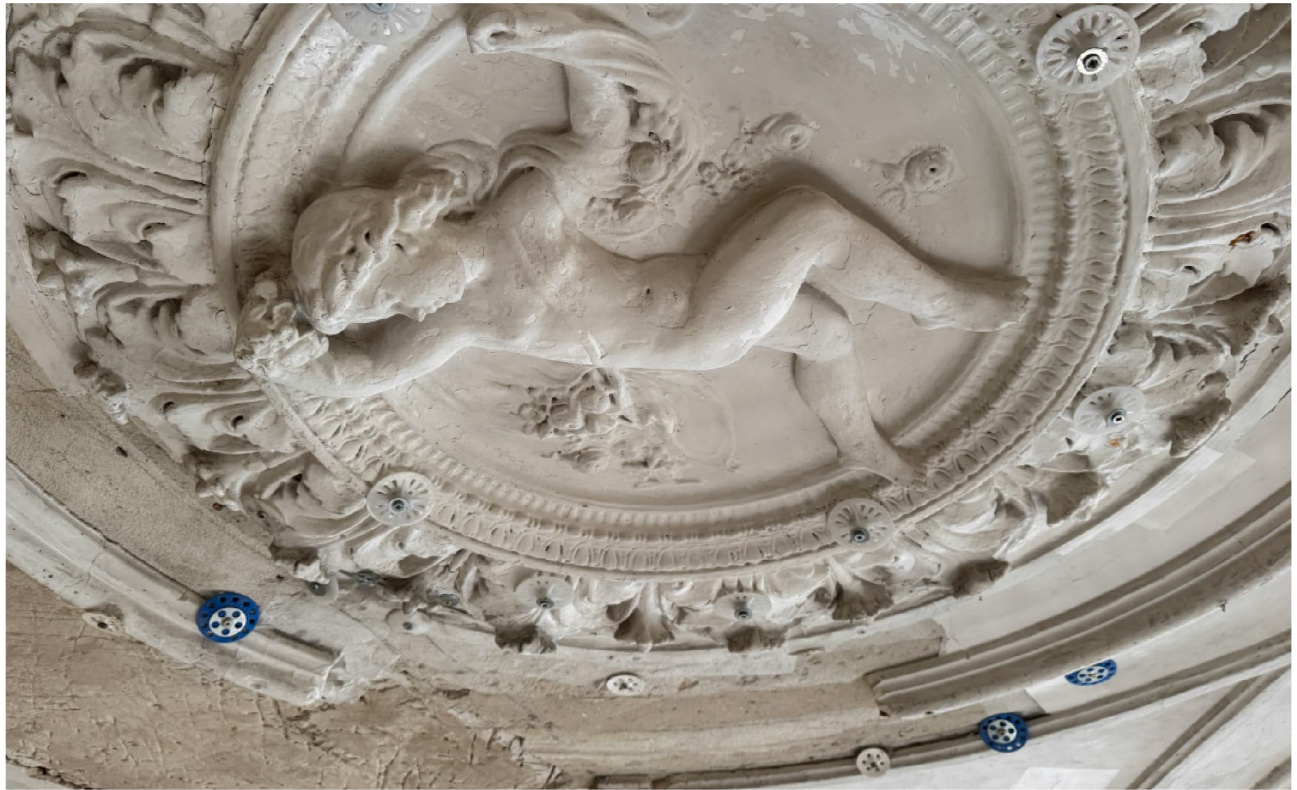
Abb. 17 20206-03-06 ML_028 OR.JPG Östliche Pflanzenhalle - Deckenmedaillon, Joch 1
