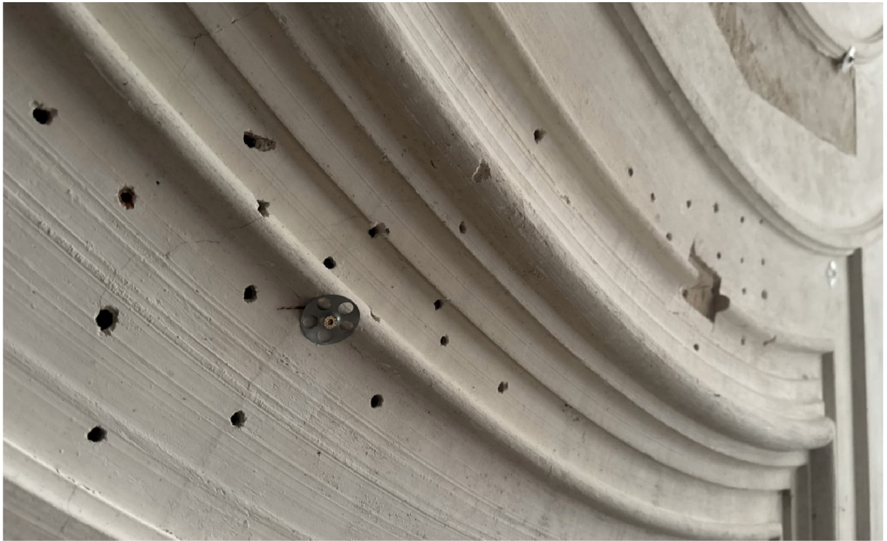
Abb. 22 IMG_9466.JPG Östliche Pflanzenhalle - Lochansammlung durch Abspreiung der Decke für Sanierungsarbeiten am Dachstuhl
